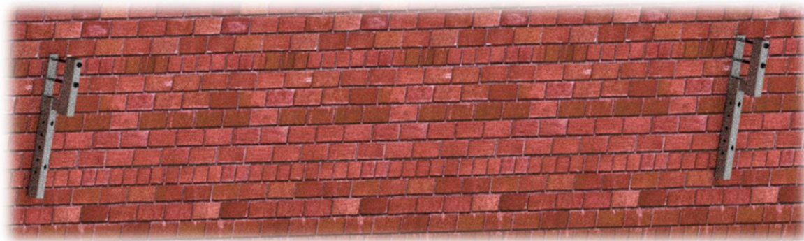
Rys. 15. Rozmieszenie łączników przyściennych.
